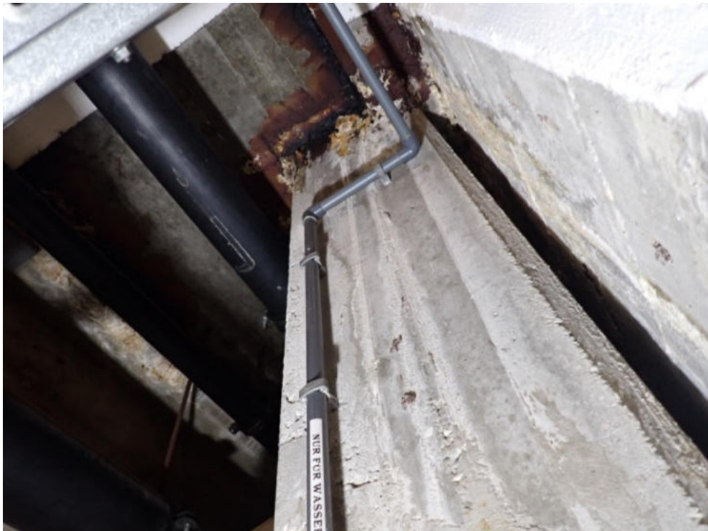
Bild 28: Untersuchungsbereich 23 im Erdgeschoss/ Technikbereich – Stütze
