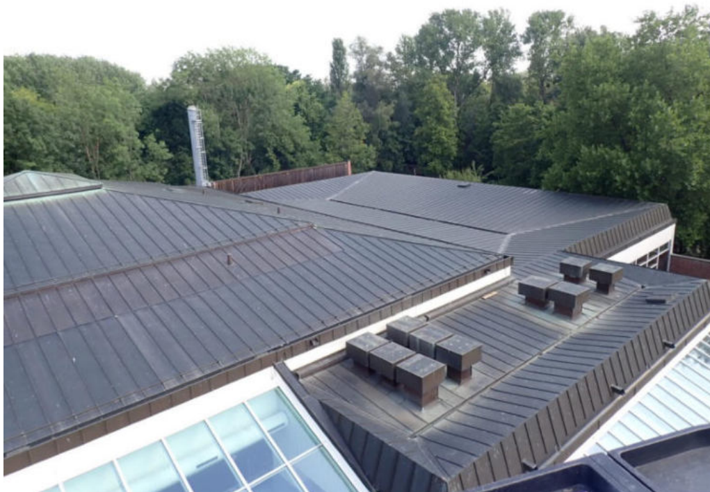
Bild 54: Untersuchungsbereich 41 - Hauptbau, Dachkonstruktion
