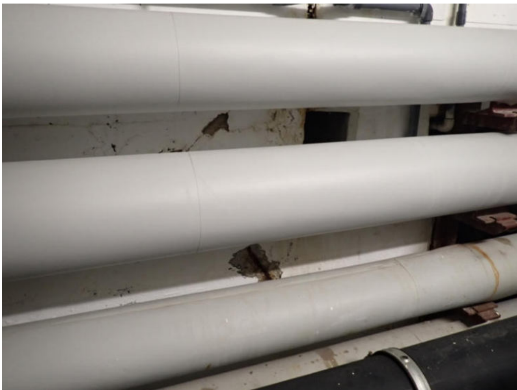
Bild 34: Riss in Beckenwand nahe Untersuchungsbereich 9 im Erdgeschoss/ Technikbereich
