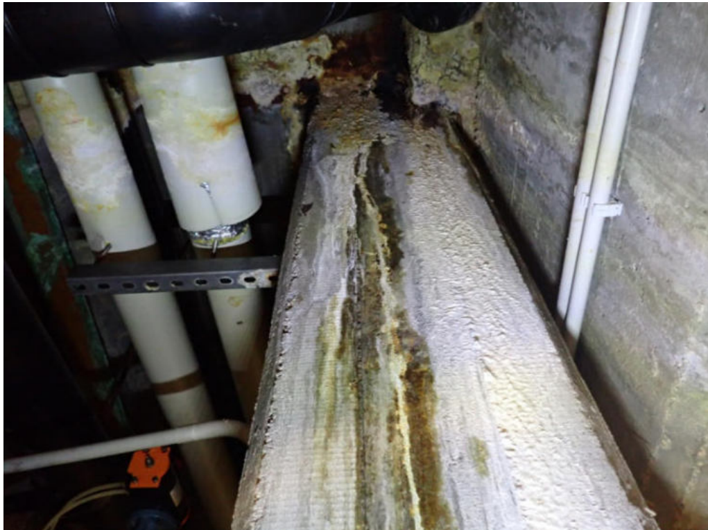
Bild 21: Untersuchungsbereich 17 im Erdgeschoss/ Technikbereich
