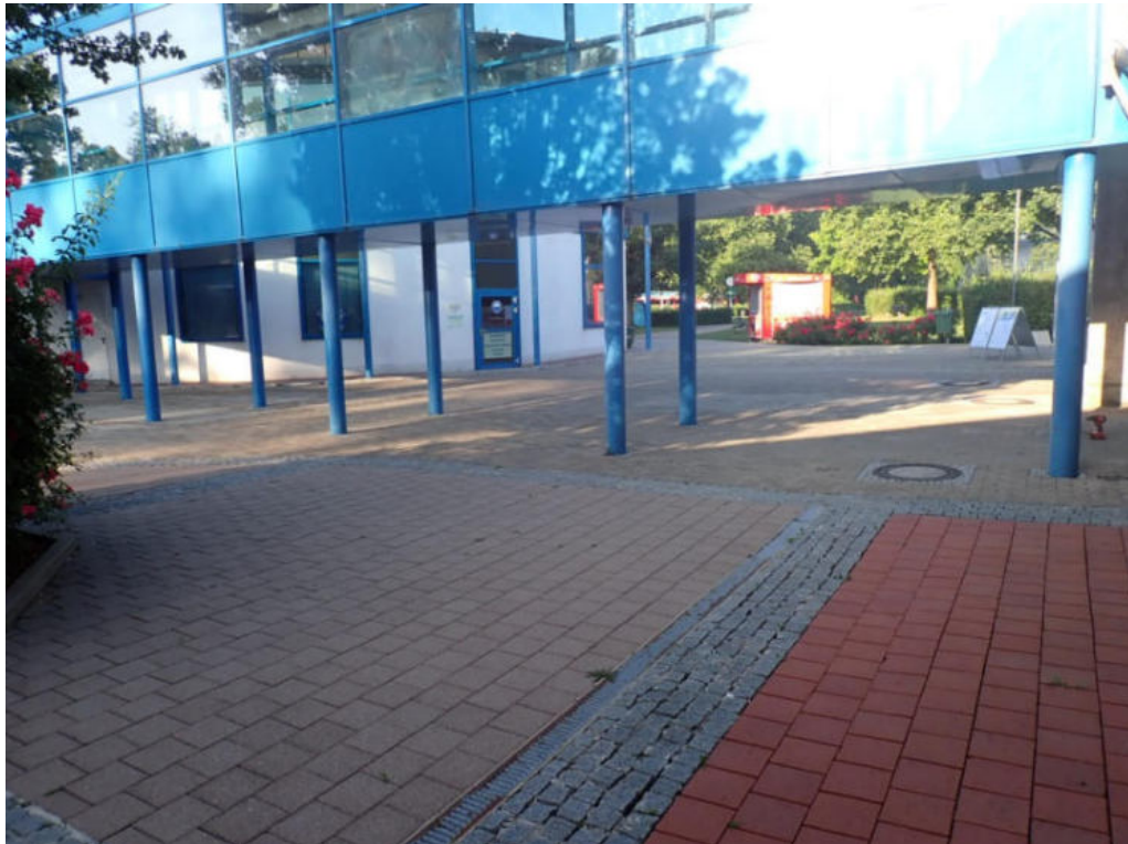
Bild 25: Ansicht Übergang zum Erweiterungsbau
