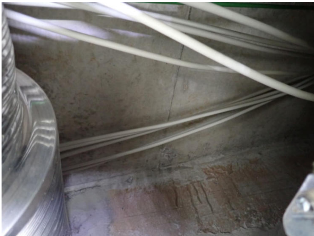
Bild 68: Untersuchungsbereich 58, Ergänzungsbau im OG
