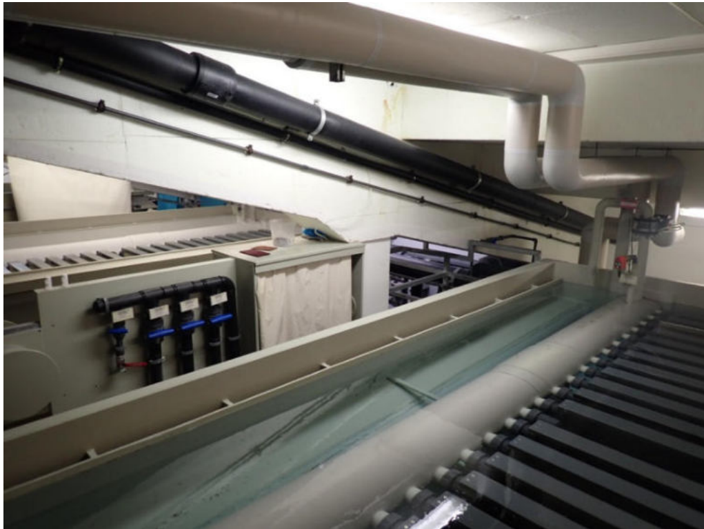
Bild 17: Untersuchungsbereich 12 im Erdgeschoss/ Umwälzanlage - Technik
