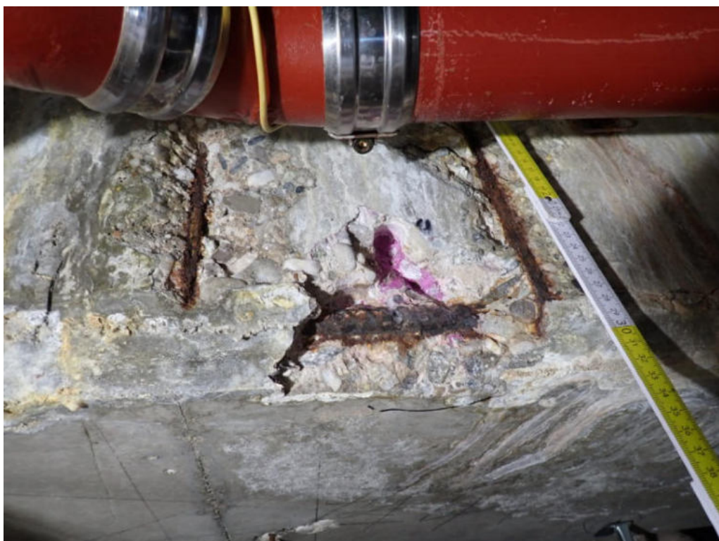
Bild 36: Untersuchungsbereich 27 im Erdgeschoss/ Sauna
