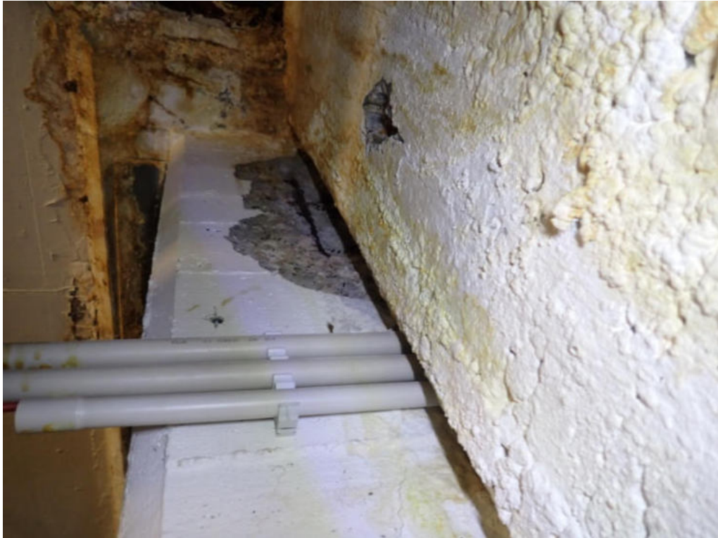
Bild 33: Untersuchungsbereich 25 im Erdgeschoss/ Technik – Stütze, Becken
