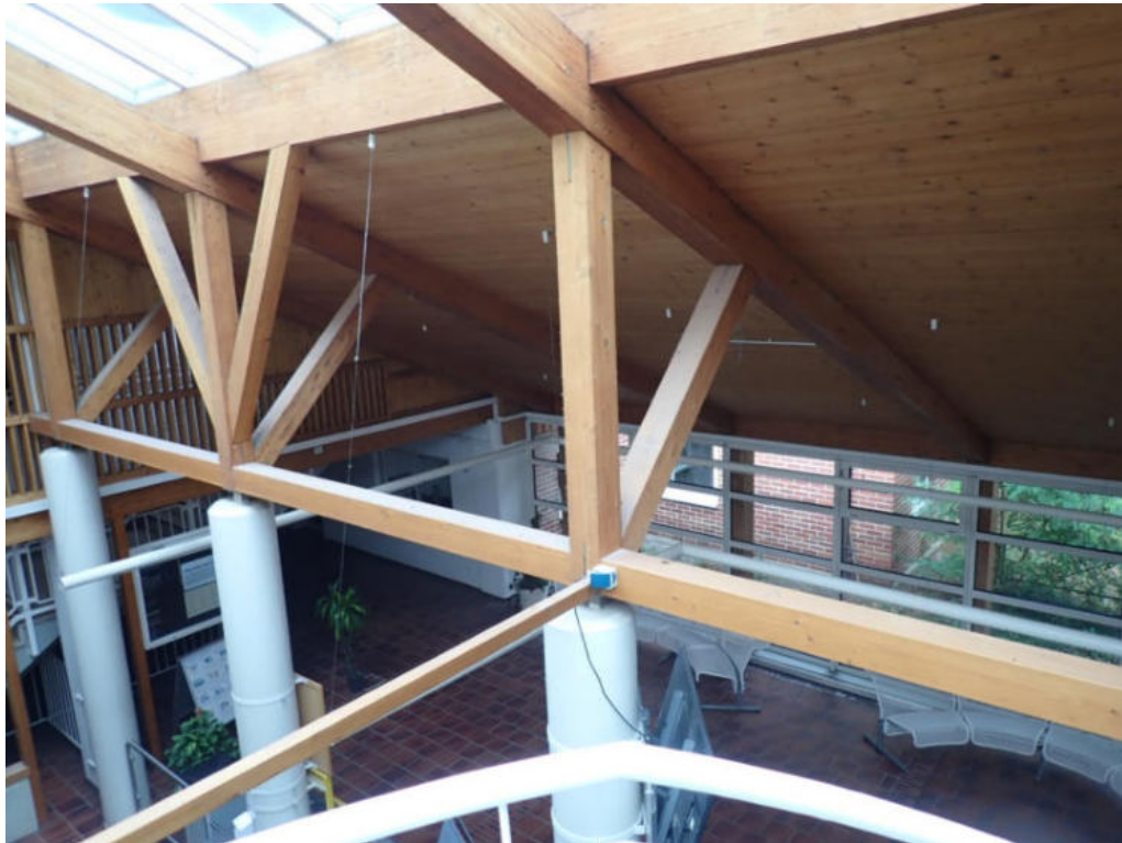
Bild 43: Untersuchungsbereich 34 im Obergeschoss/ vor Cafeteria, Foyer
