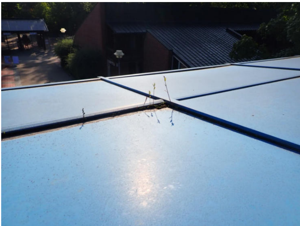
Bild 48: Untersuchungsbereich 37 - Übergang Ergänzungsbau, Dach
