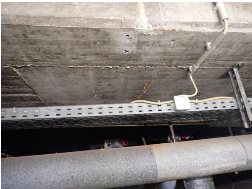
Bild 24: Nahe Untersuchungsbereich 19 im Erdgeschoss/ Technikbereich, Beckenunterseite
