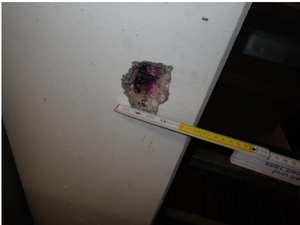
Bild 18: Untersuchungsbereich 12 im Erdgeschoss/ Umwälzanlage - Technik
