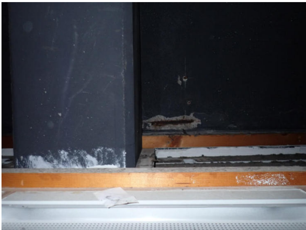
Bild 10: Untersuchungsbereich 5 im Obergeschoss, Stütze und Randriegel
