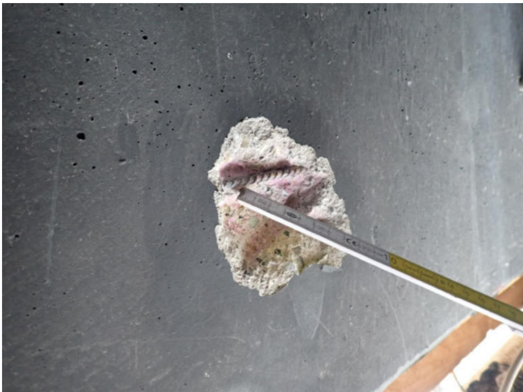
Bild 8: Untersuchungsbereich 2a im Obergeschoss, Aufschlussstelle Randriegel
