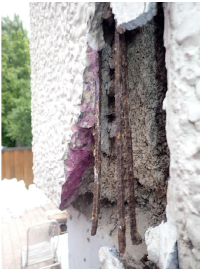
Bild 41: Untersuchungsbereich 31 – Fassadenplatte bei Gebäudeecke, nach Aufschlüssen
