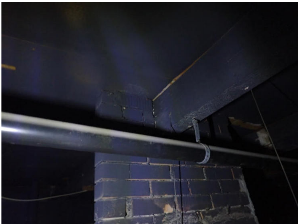
Bild 58: Untersuchungsbereich 51 im Obergeschoss, Garderobenbereich
