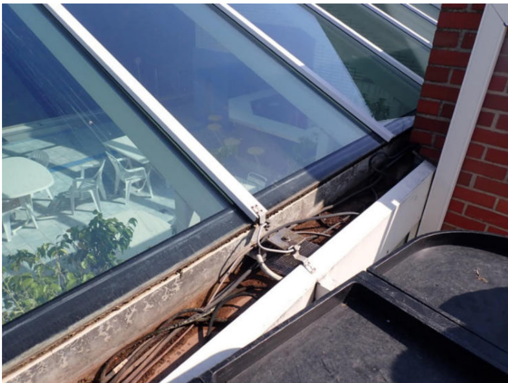
Bild 52: Untersuchungsbereich 41 - Hauptbau, Dachrinne mit Kabeln
