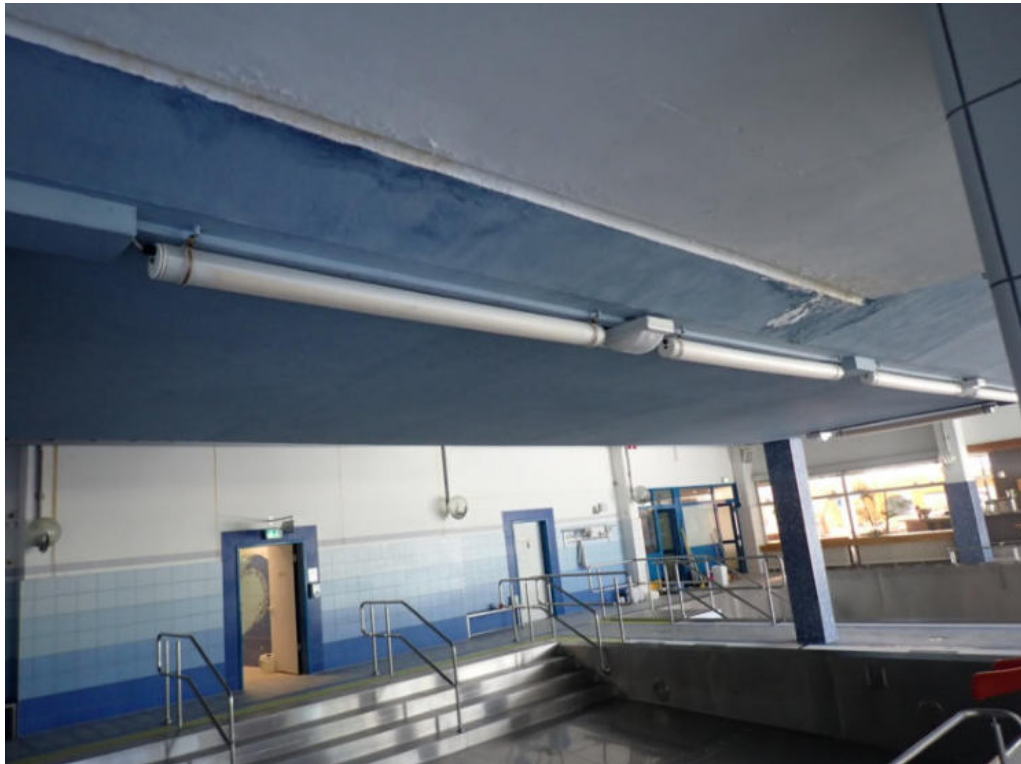
Bild 11: Untersuchungsbereich 6 im Obergeschoss
