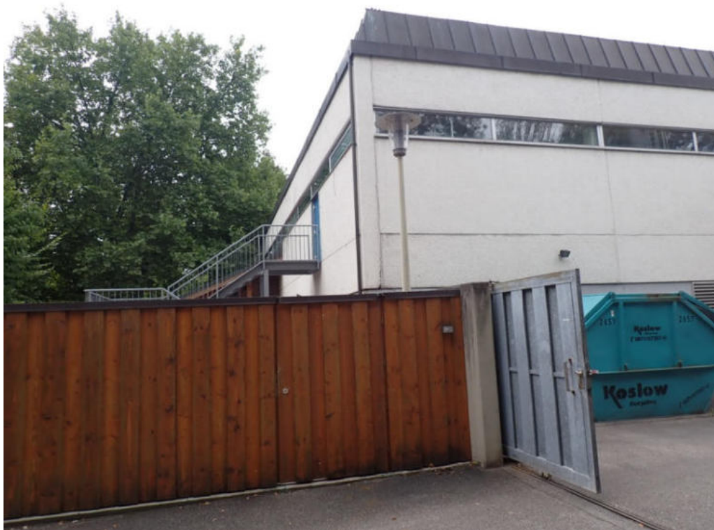
Bild 39: Untersuchungsbereich 31– Fassadenplatte bei Gebäudeecke
