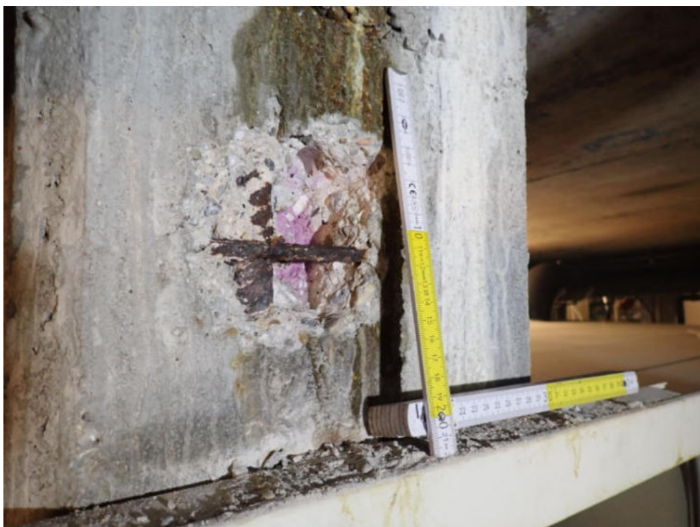
Bild 22: Untersuchungsbereich 17 im Erdgeschoss/ Technikbereich
