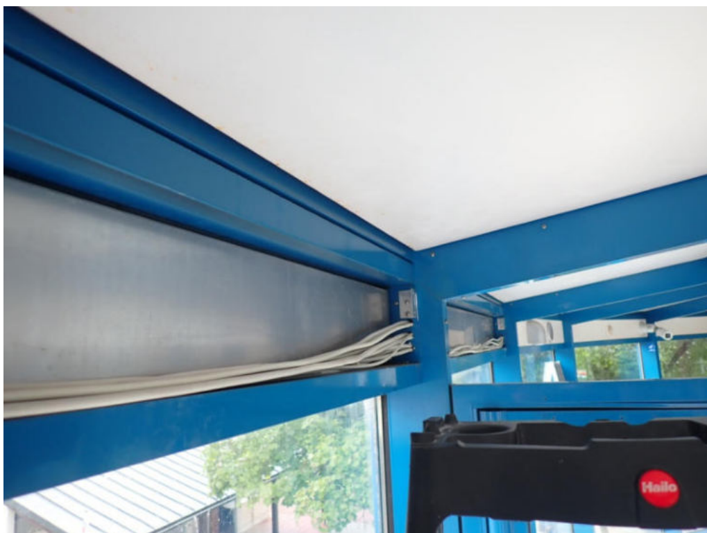
Bild 66: Untersuchungsbereich 57, Übergang Ergänzungsbau im OG
