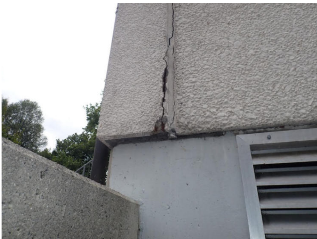
Bild 40: Untersuchungsbereich 31– Fassadenplatte bei Gebäudeecke
