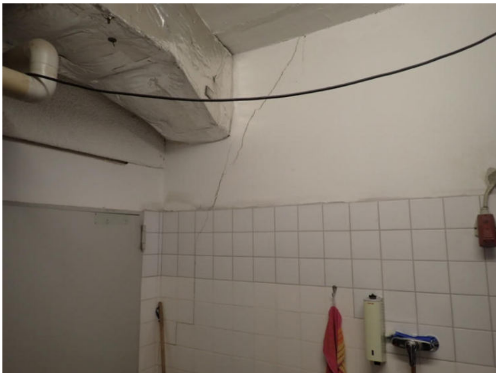
Bild 20: Untersuchungsbereich 15 im Erdgeschoss/ Waschraum - Technik
