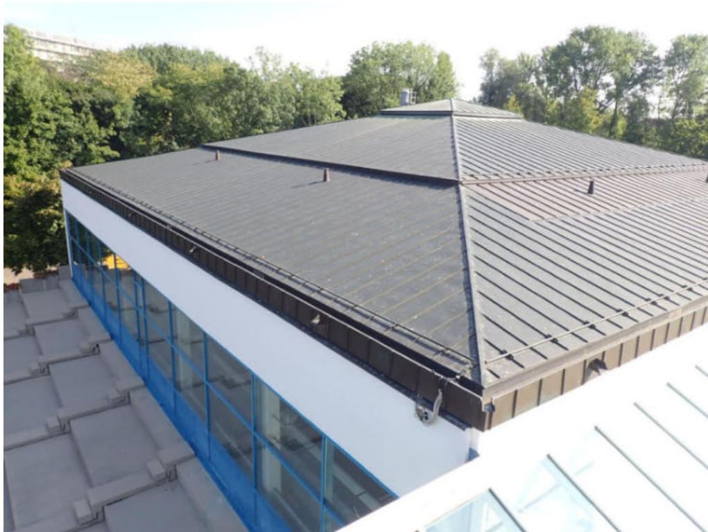
Bild 49: Untersuchungsbereich 38 - Dach über Hallenbadbecken
