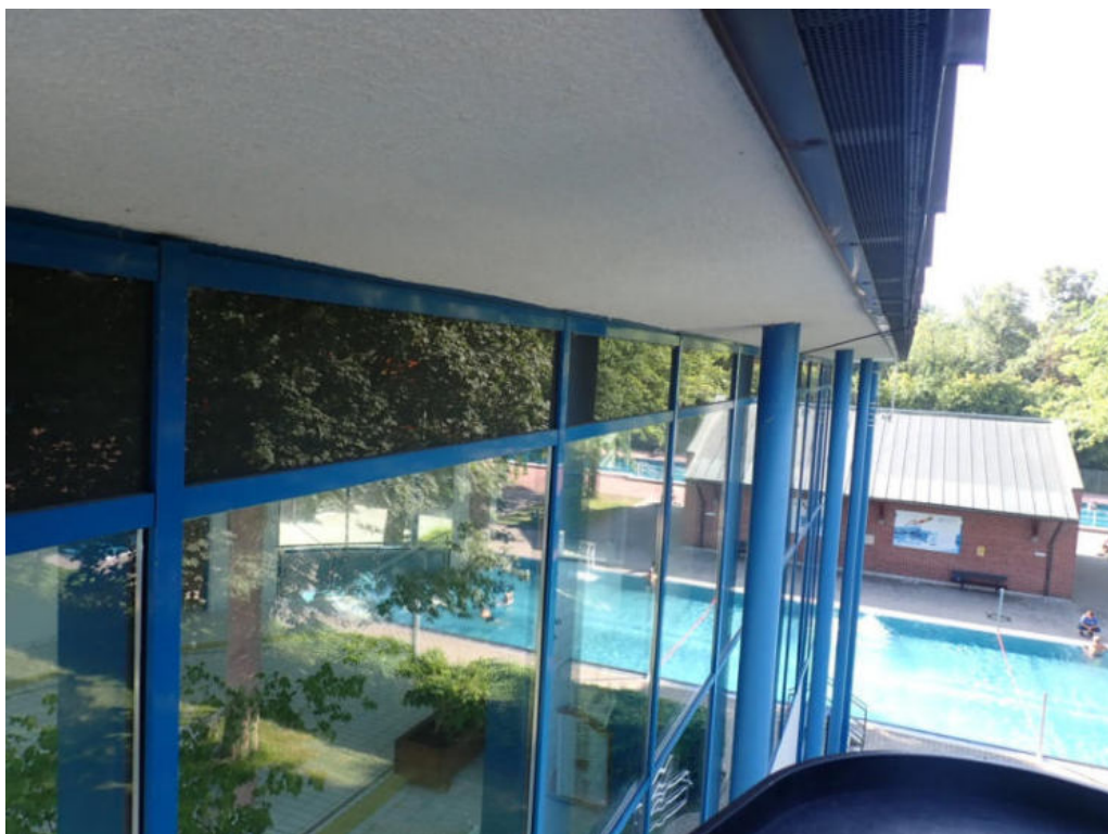
Bild 50: Untersuchungsbereich 39 - Ergänzungsbau, Außen
