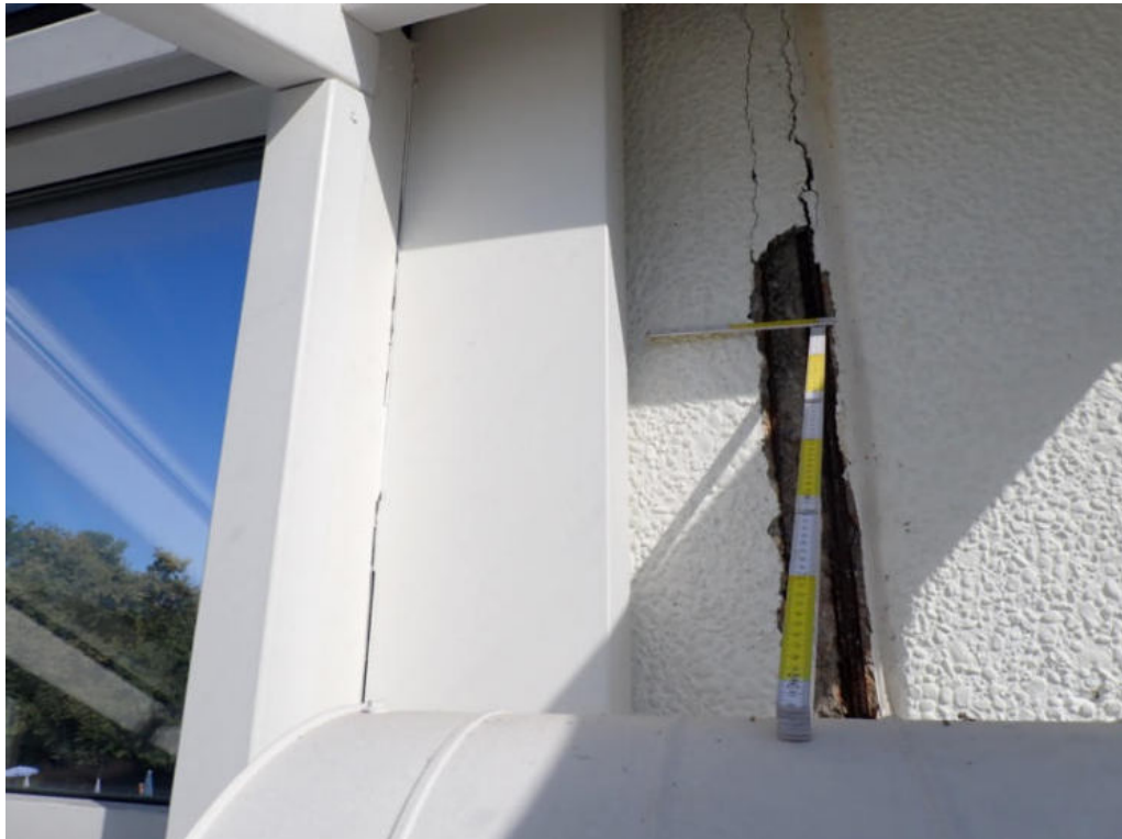
Bild 5: Untersuchungsbereich 2 im Obergeschoss
