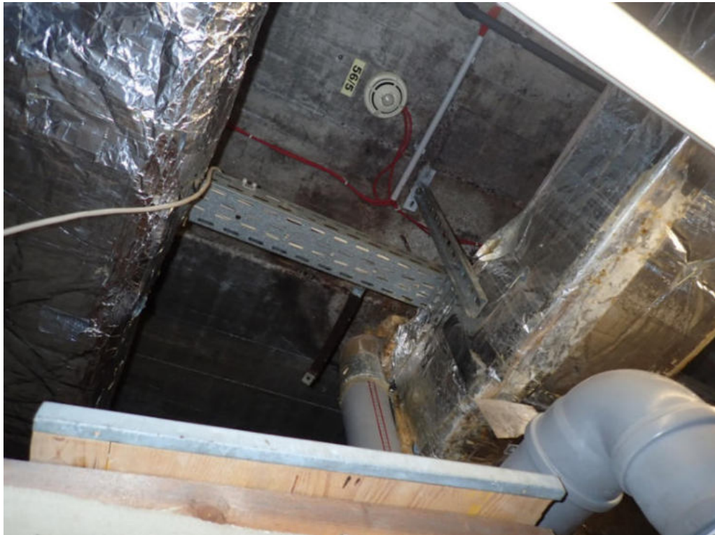
Bild 37: Untersuchungsbereich im Saunabereich/ Erdgeschoss (siehe Planskizze)
