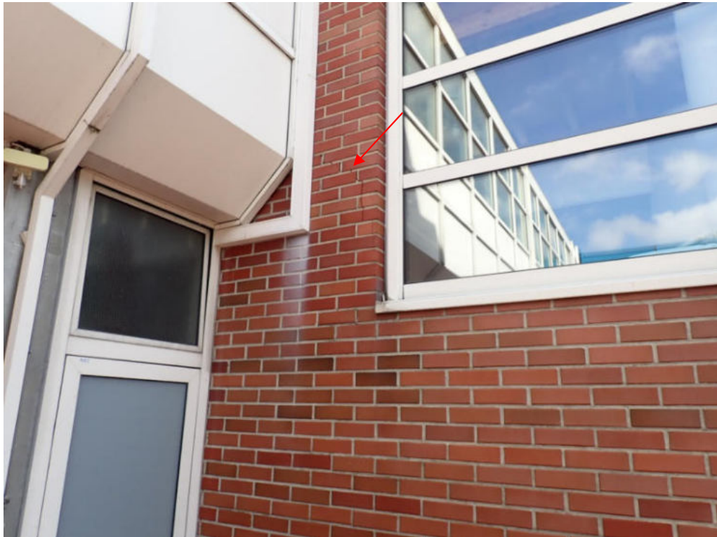
Bild 55: Untersuchungsbereich 42 - Schrägriss Mauerwerk
