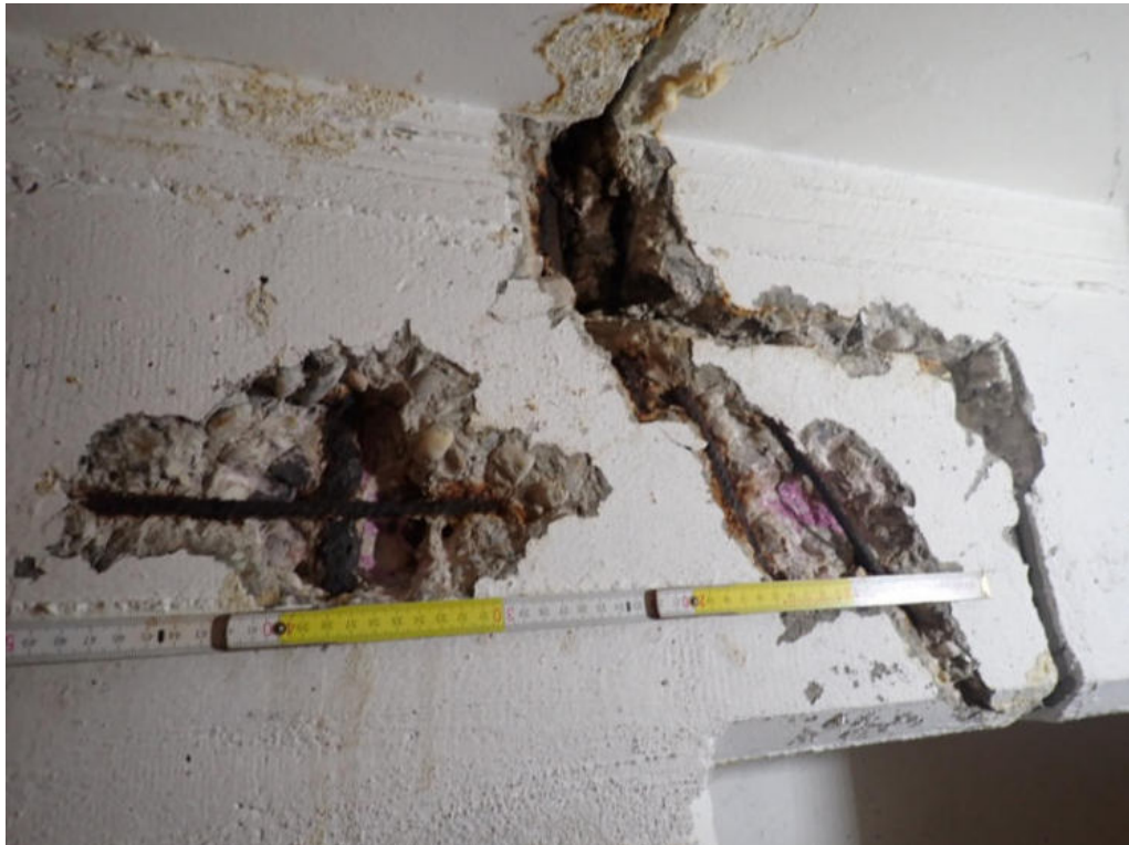
Bild 15: Untersuchungsbereich 10 im Erdgeschoss/ Technikbereich
