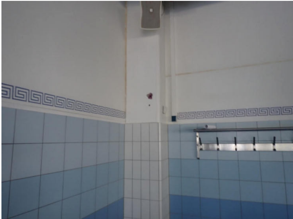
Bild 9: Untersuchungsbereich 4 im Obergeschoss, Stütze
