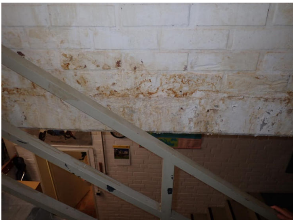
Bild 38: Untersuchungsbereich 30 im Erdgeschoss/ Treppe bei Saunabereich
