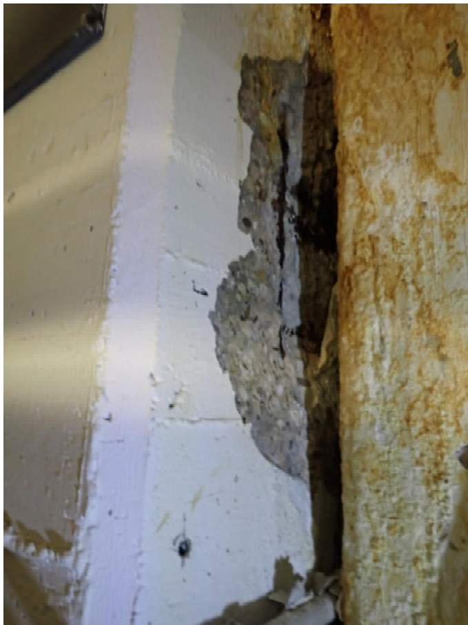
Bild 32: Untersuchungsbereich 25 im Erdgeschoss/ Technik – Stütze, Becken
