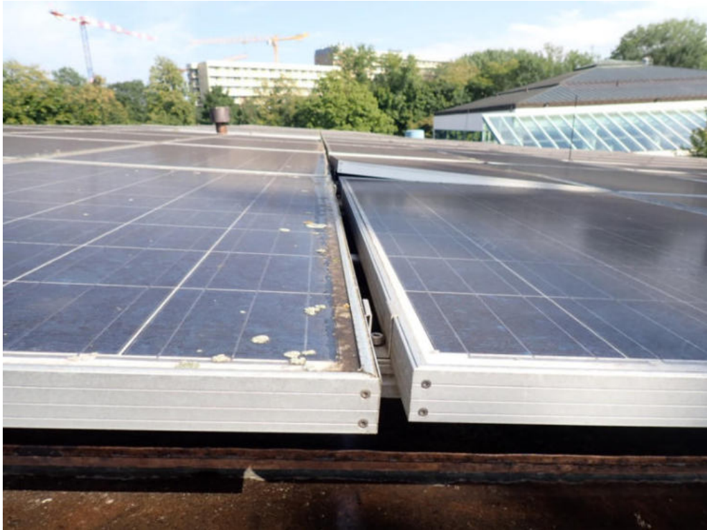
Bild 51: Untersuchungsbereich 40 - Ergänzungsbau, Außen – PV-Platte mit nach oben ragender Ecke
