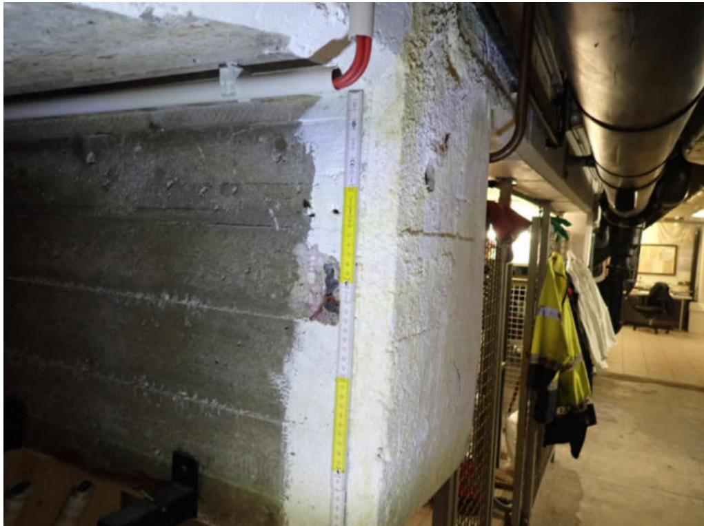
Bild 35: Untersuchungsbereich 26 im Erdgeschoss/ Technikbereich – Unterzug
