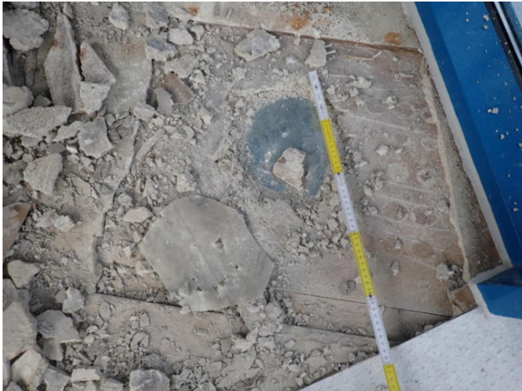
Bild 65: Untersuchungsbereich 55, Übergang Ergänzungsbau im OG
