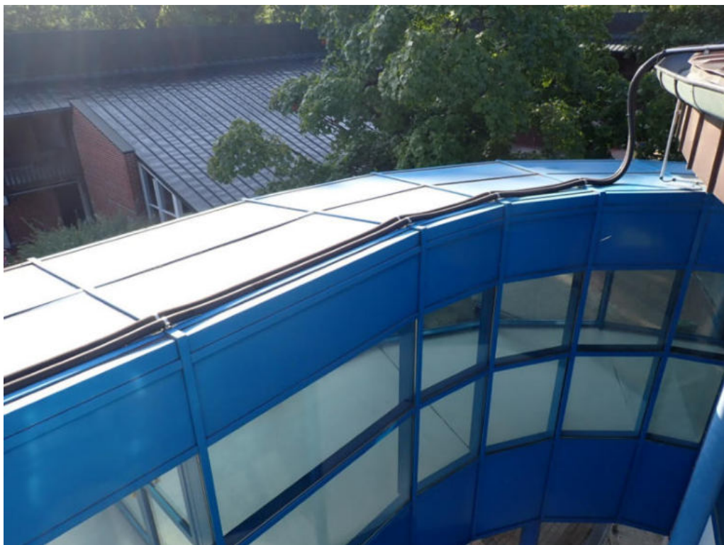
Bild 46: Untersuchungsbereich 37 - Übergang Ergänzungsbau, Außen
