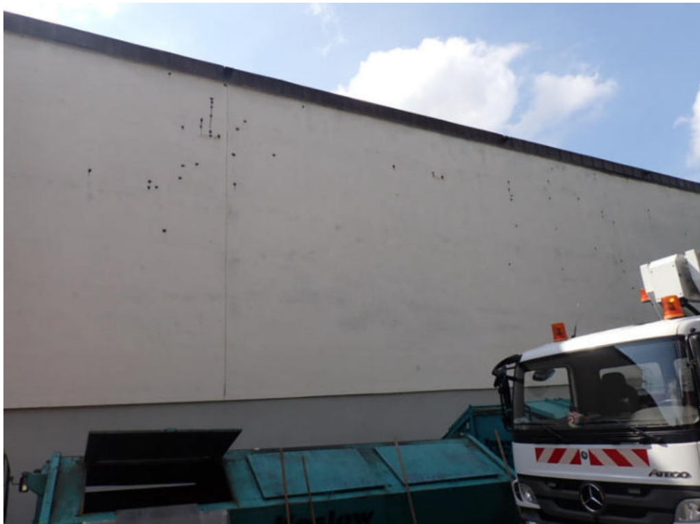
Bild 56: Untersuchungsbereich 43 - Hauptbau, Fassade
