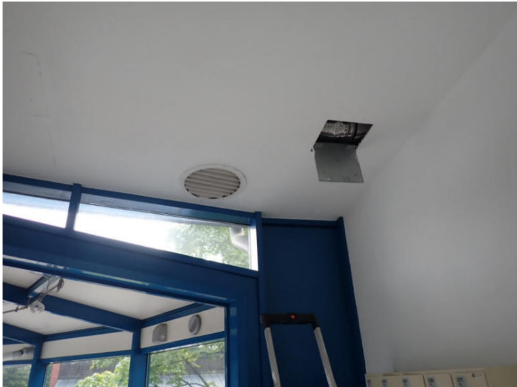
Bild 67: Untersuchungsbereich 58, Ergänzungsbau im OG
