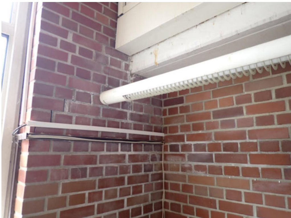
Bild 60: Untersuchungsbereich 54 im OG und EG, Kraftraum (Schrägriss Wand)
