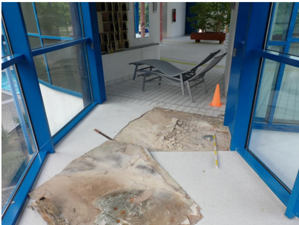
Bild 64: Untersuchungsbereich 55, Übergang Ergänzungsbau im OG
