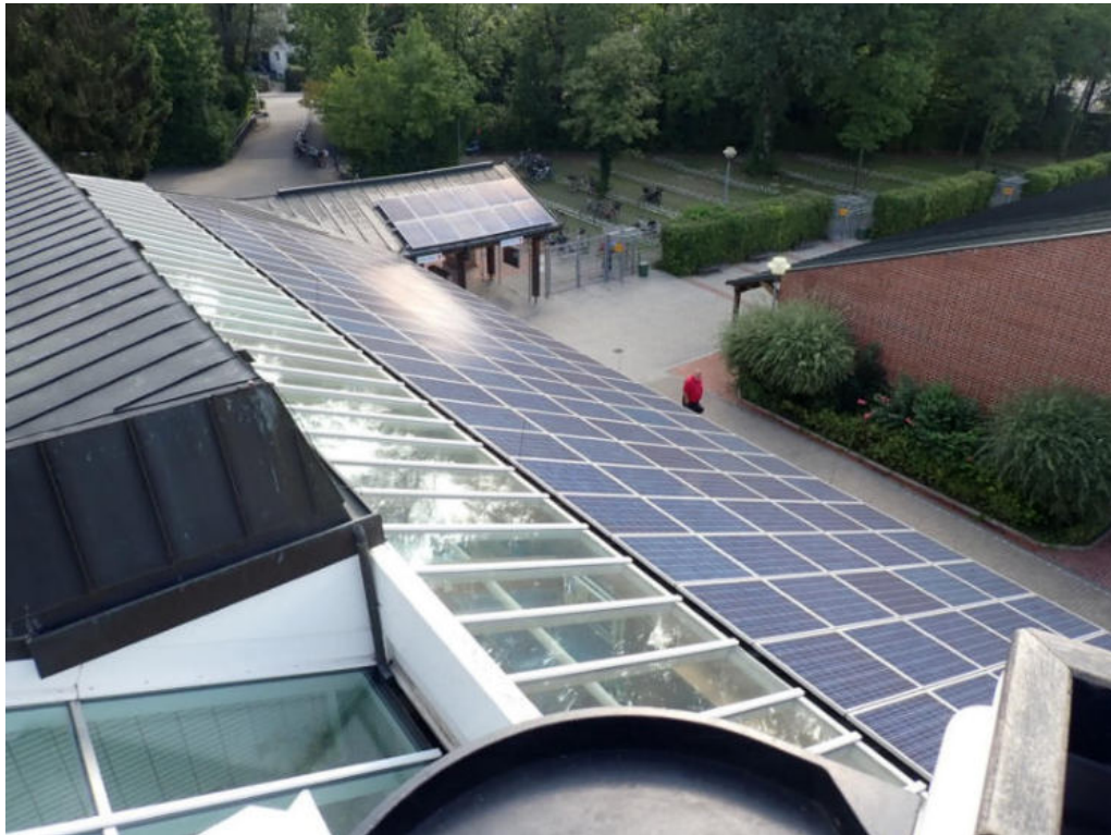
Bild 53: Untersuchungsbereich 41 - Hauptbau, Dachkonstruktion
