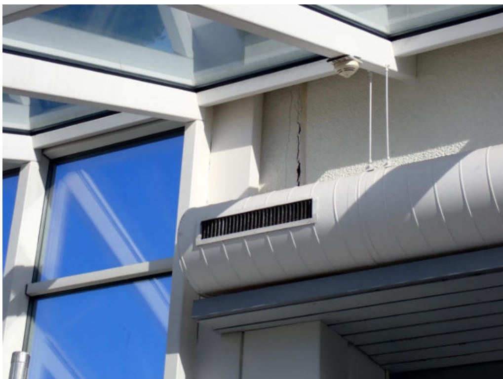
Bild 4: Ansicht Hallenbadbereich im Obergeschoss, Untersuchungsbereich 2
