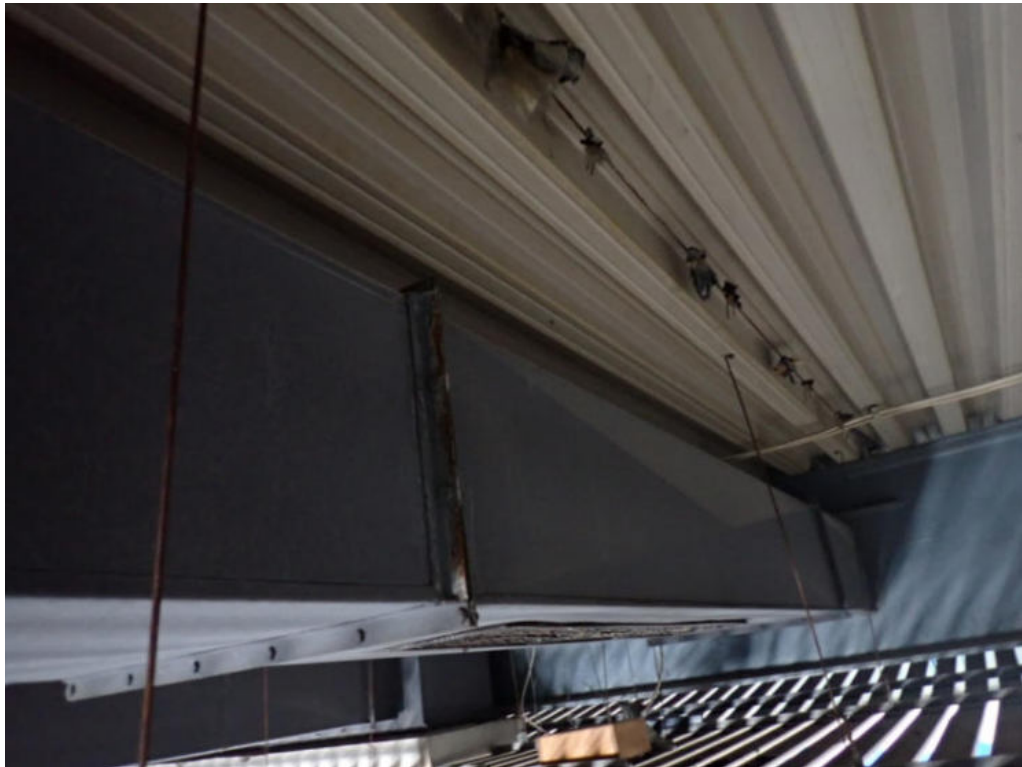
Bild 13: Untersuchungsbereich 7 im Obergeschoss (über Empore)
