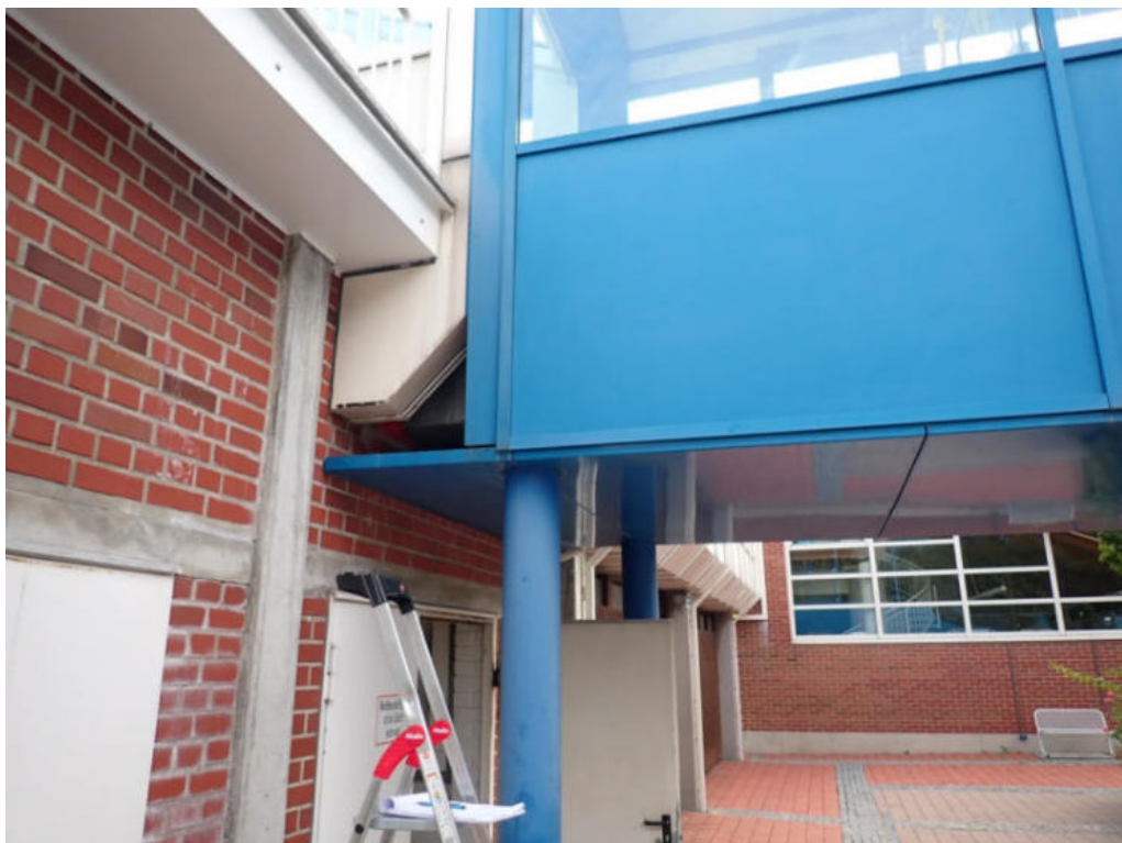
Bild 62: Untersuchungsbereich 55, Übergang Ergänzungsbau
