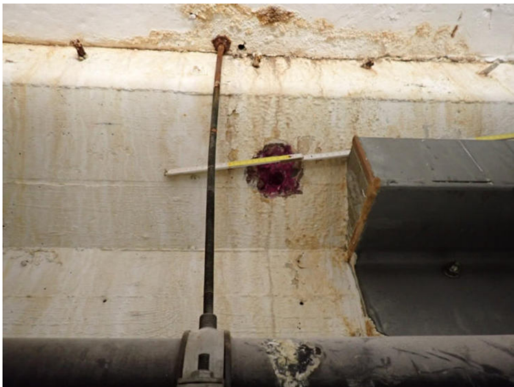
Bild 14: Untersuchungsbereich 9 im Erdgeschoss/ Technikbereich
