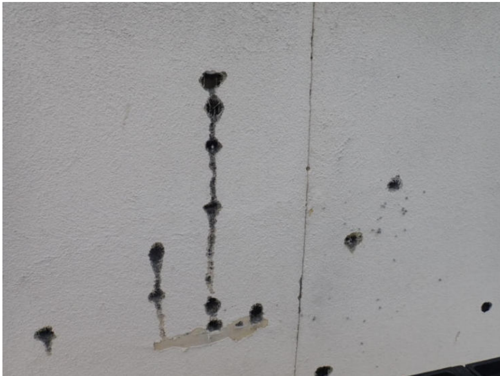
Bild 57: Untersuchungsbereich 43 - Hauptbau, Fassade – Löcher in der Fassadendämmung durch Vögel
