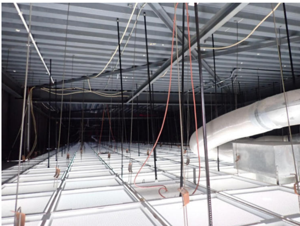
Bild 6: Untersuchungsbereich 2a im Obergeschoss, untergehängte Decke
