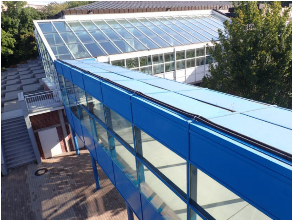
Bild 47: Untersuchungsbereich 37 - Übergang Ergänzungsbau, Außen
