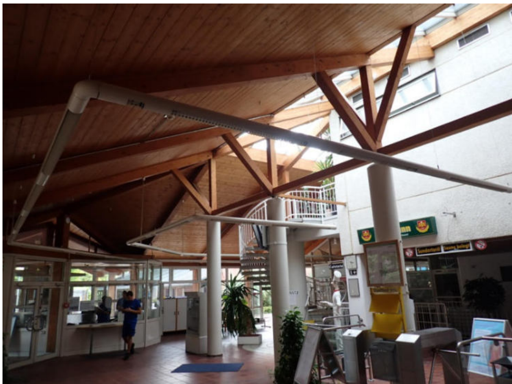
Bild 44: Untersuchungsbereich 34 im Foyer
