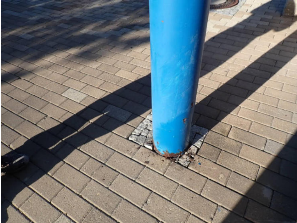
Bild 27: Untersuchungsbereich 20, Stahlstütze Übergang zum Erweiterungsbau
