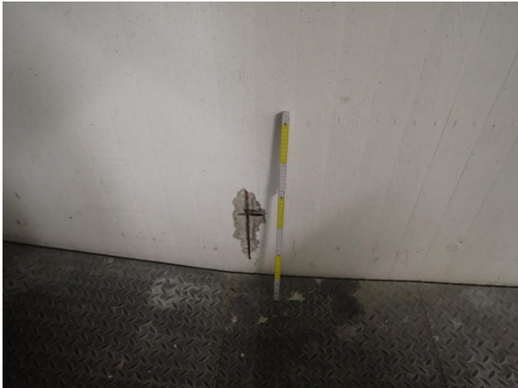
Bild 19: Untersuchungsbereich 13 im Erdgeschoss/ Umwälzanlage - Technik
