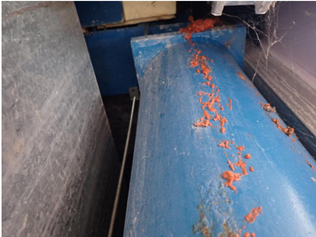
Bild 63: Untersuchungsbereich 55, Übergang Ergänzungsbau
